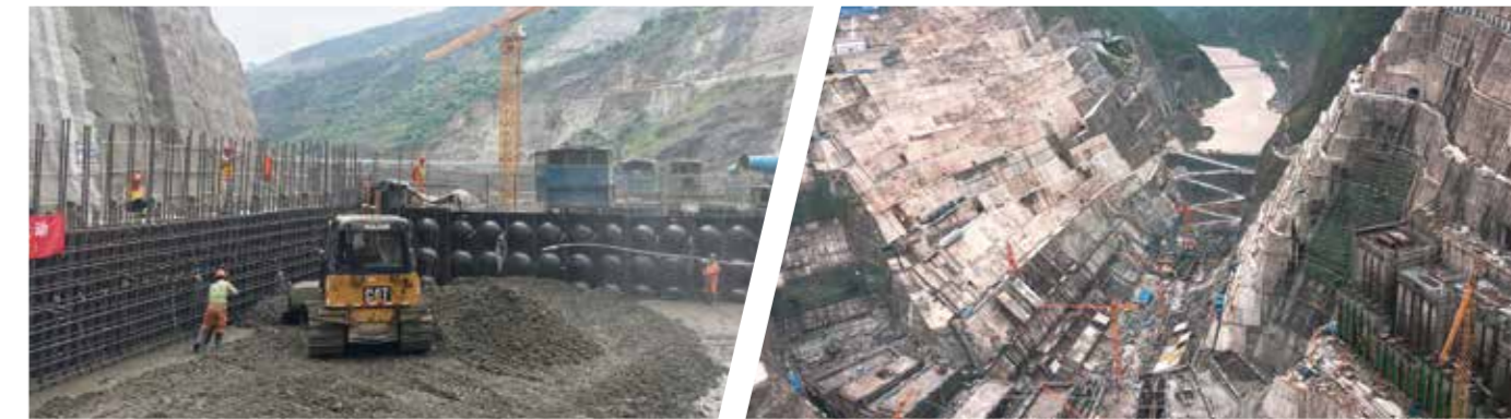
【司南导航助力白鹤滩水电站打造智慧工程】
