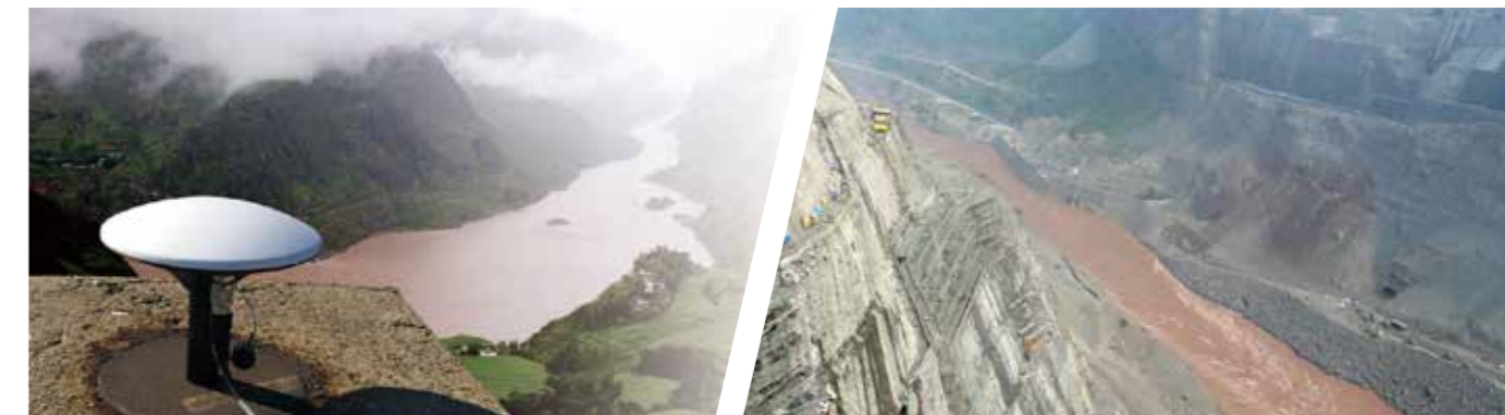
【溪洛渡水电站库区地灾滑坡体自动化监测】
